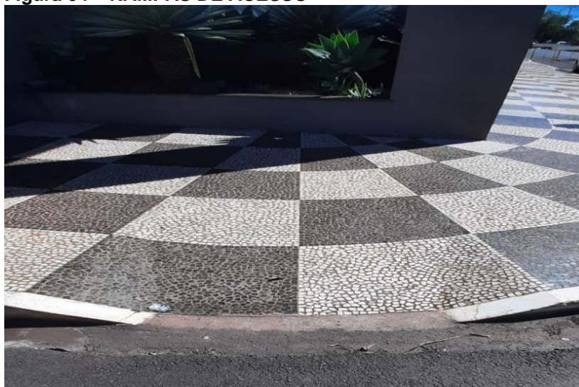
Figura 04 – RAMPAS DE ACESSO
