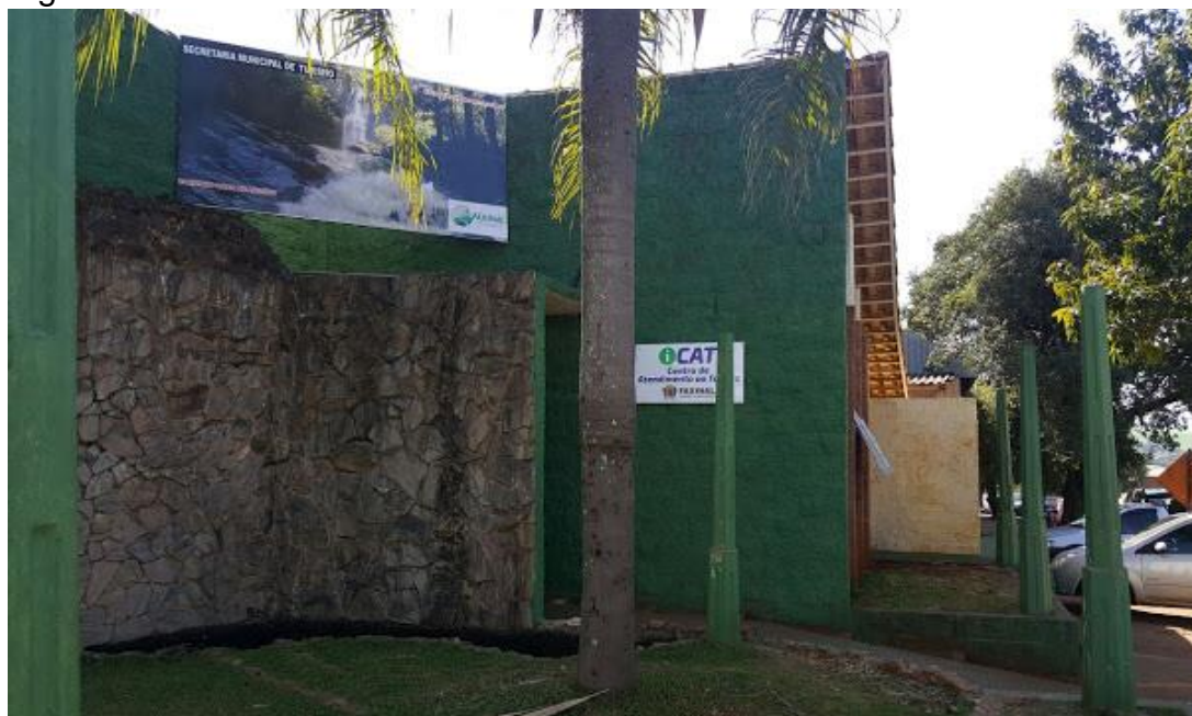
Figura 27 - Área externa do CAT de Faxinal
