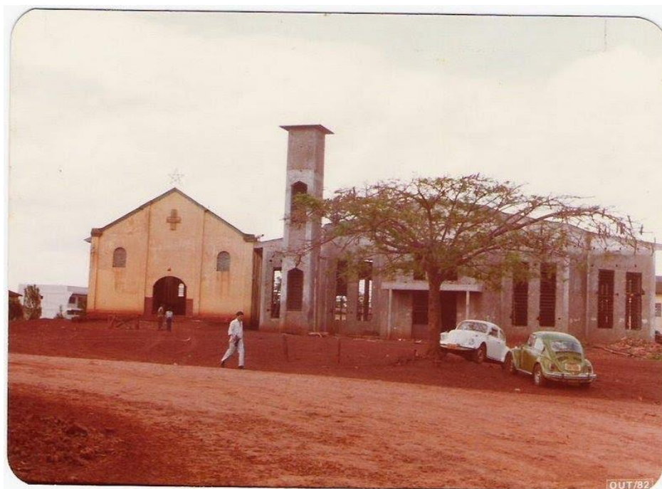
Figura 9 - Início da construção da Igreja Matriz de Lunardelli, na década de 1980. Fonte: Santuário (2015).
